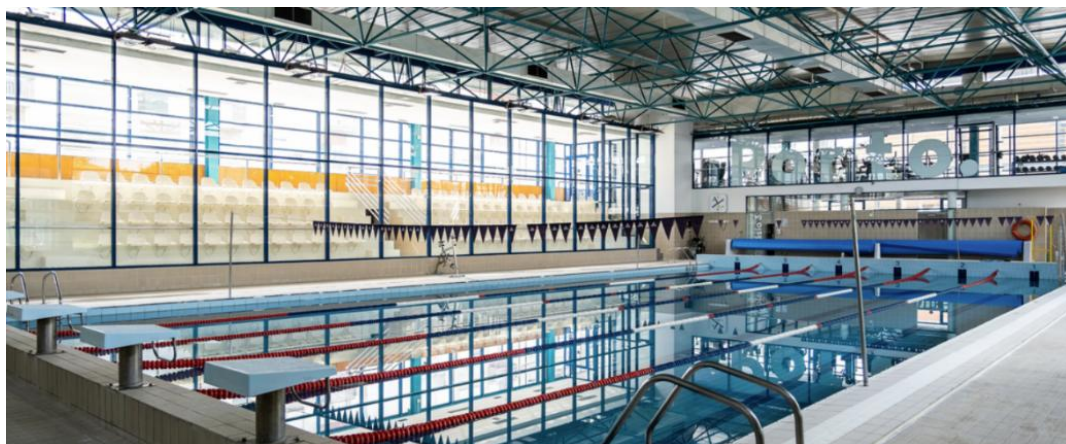
Figura 36 - Piscina da Constituição
