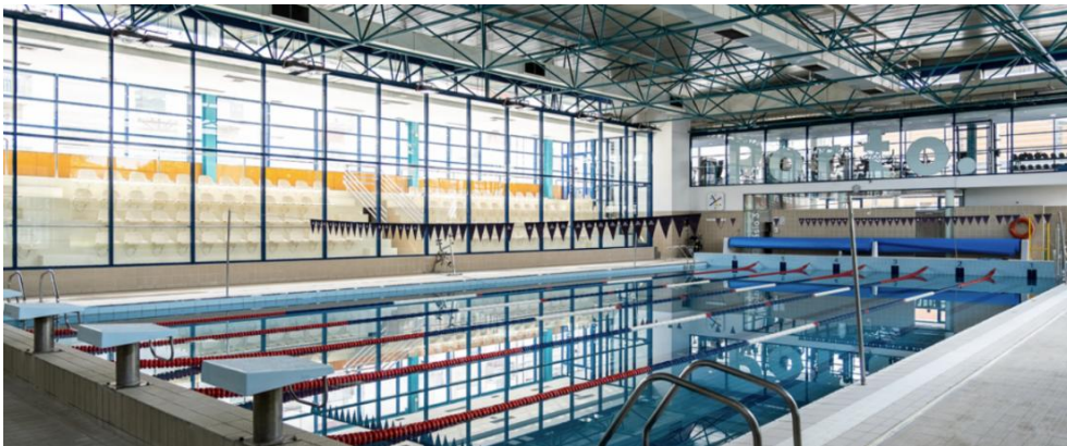
Figura 28 - Piscina da Constituição
